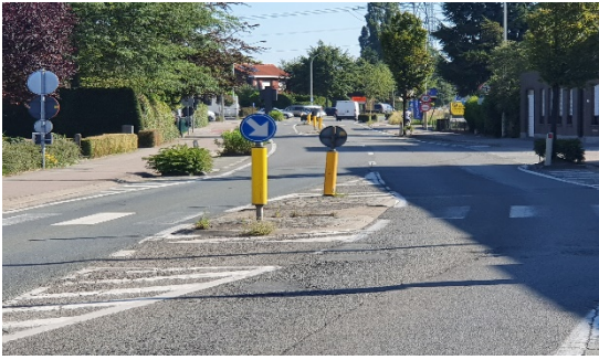
Pierstraat middenberm t.h.v 140
