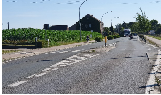
Pierstraat middenberm t.h.v 92
